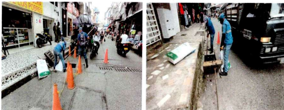
Mantenimiento de sumideros zona centro y Pueblo nuevo.
