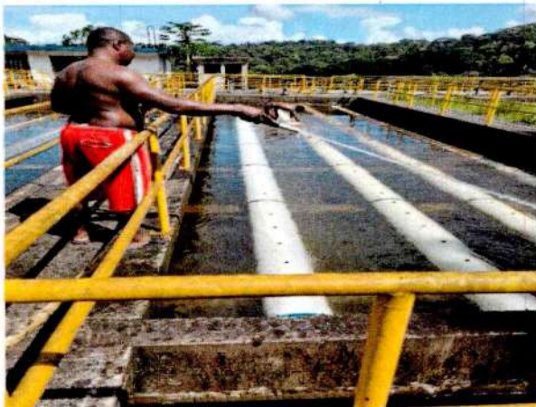
Mantenimiento a infraestructura de tratamiento sedimentadores
