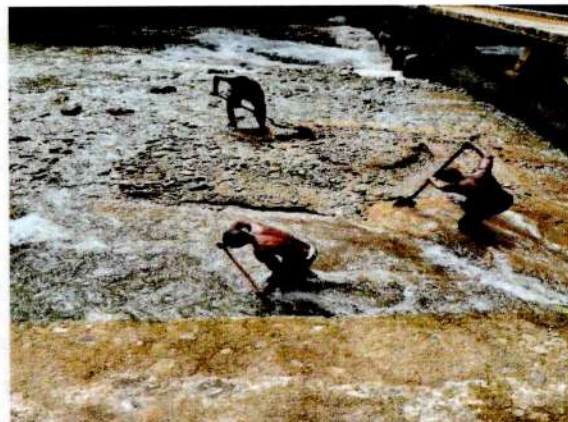
Mantenimiento y dragado de bocatoma planta escalerete
