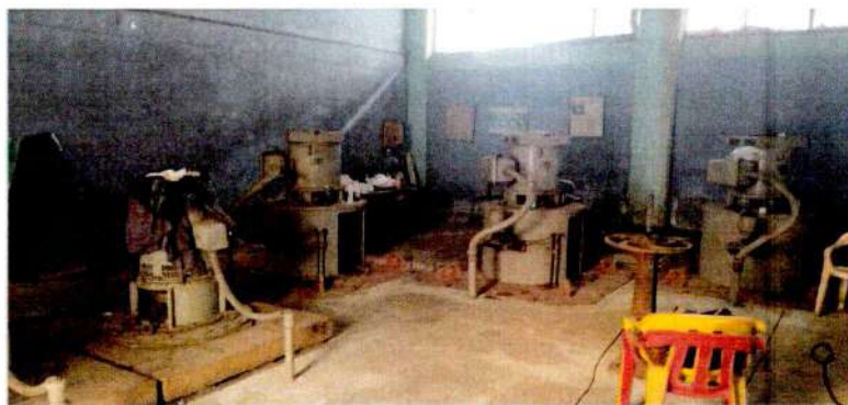
Foto. Ubicación EBAR Pueblo Nuevo.
