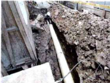
Barrio Transformación Carrera 54 Calle 1sur
